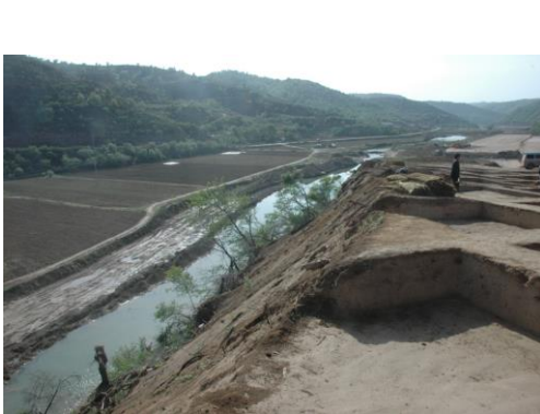
a. 葫蘆河岸の直道盛土
